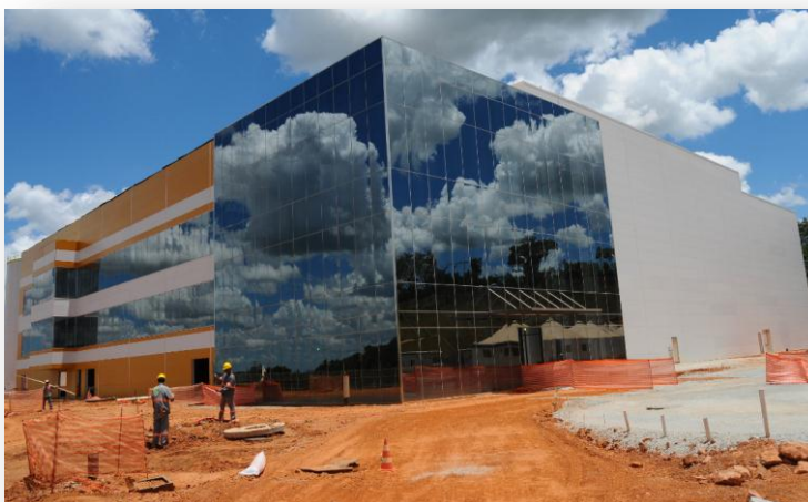
Fábrica de semicondutores (chips) UNITEC, em fase de construção em Ribeirão das Neves, na RMBH
