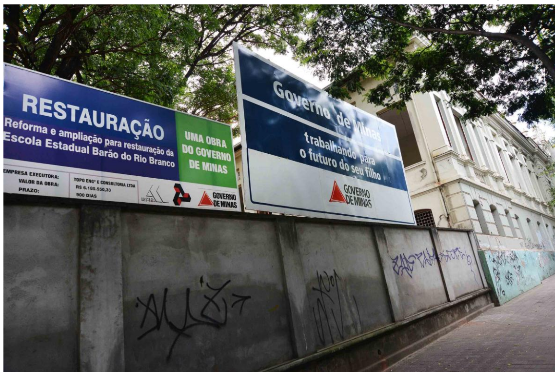
Obra de reforma e restauração da tradicional Escola Estadual Barão do Rio Branco, em Belo Horizonte
